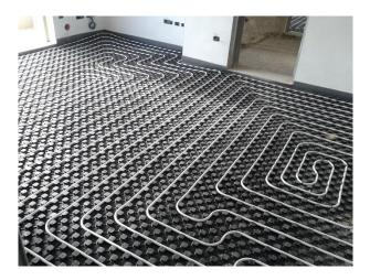
L'impianto di riscaldamento sarà del tipo a pavimento e sarà suddiviso in tre zone (zona giorno, zona notte e bagni); ciascuna delle citate zone sarà dotata di termostato ambientale.
