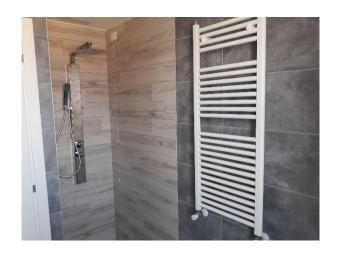
Nei bagni, oltre al riscaldamento a pavimento, verrà installato un radiatore di tipo scalda salviette collegato all'impianto di riscaldamento a pavimento.
